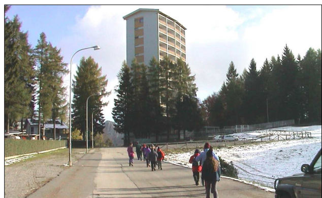
Il grattacielo a Piani Resinelli: per dare un alloggio con vista panoramica a pochi, si è rovinato un bellissimo ambiente naturale; un esempio di uso della tecnologia che, avvantaggiando pochi, danneggia tutta la comunità.
