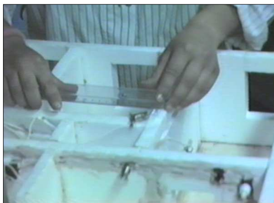
Prima di tagliare i cavi, è necessario misurare i tratti di percorso. I pezzi tagliati è bene siano abbondanti piuttosto che scarsi.
