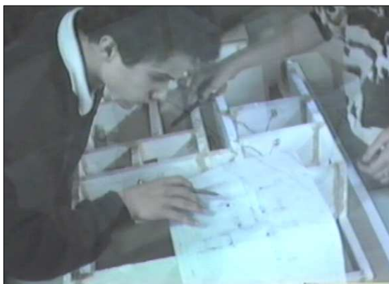
L'impianto elettrico deve essere prima progettato su una pianta. Poi i percorsi dei fili saranno disegnati sul polistirolo
